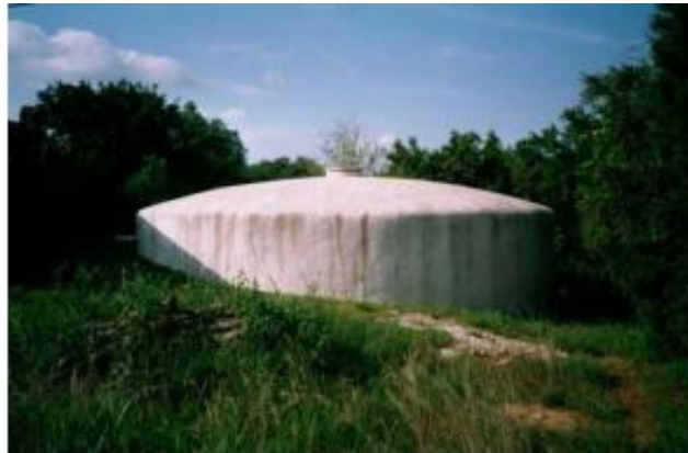
Figura 11 : Tanque de almacenamiento semienterrado
