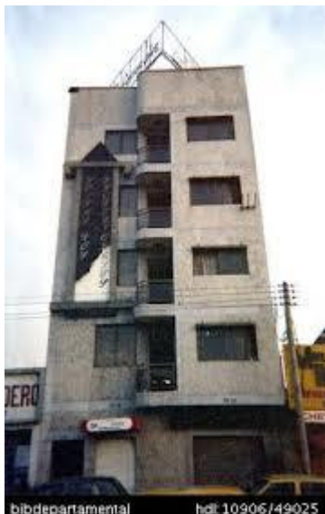
(Fotografía propia) PLANO GENERAL: SE DOCUMENTA FACHADA DEL INMUEBLE UBICADO EN LA CARRERA
