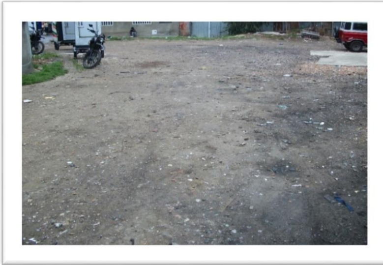
FOTOGRAFÍA 10 CALLE 66 ENTRE CARRERA 127 C Y 127 D
