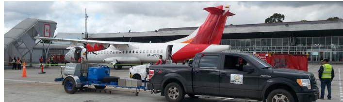
Medición de FWD y toma de información geotécnica.
