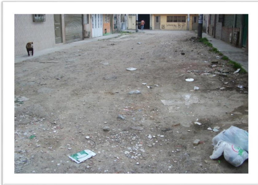
FOTOGRAFIA 4 CARRERA 119 A ENTRE CALES 63 L Y 64
