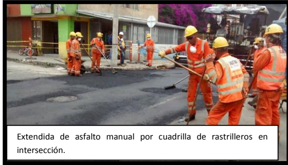
Figura No. 24 Registro fotográfico tramo 8
