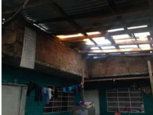
Foto 7. Mampostería perimetral sobre la placa
