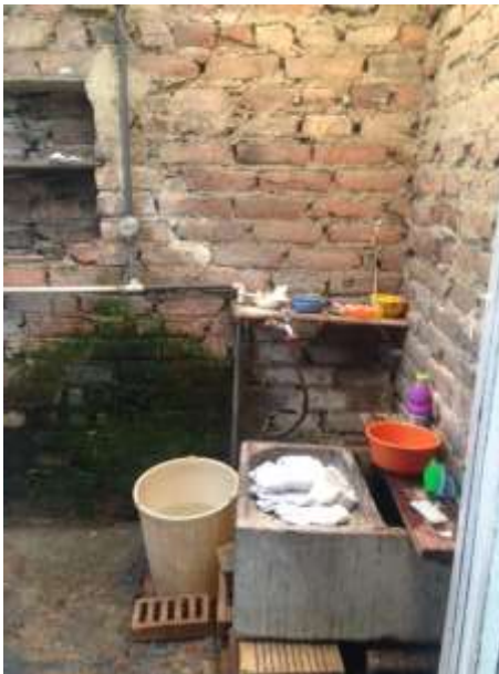
a) Zona lavandería
