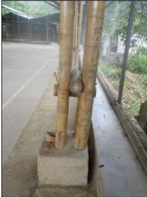
Ilustración 4. Condiciones de apoyo de la cubierta, Puerto Alegre
