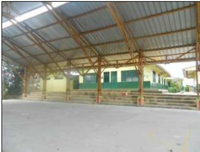
Ilustración 1. Vista general de la armadura de la cubierta La Soledad
