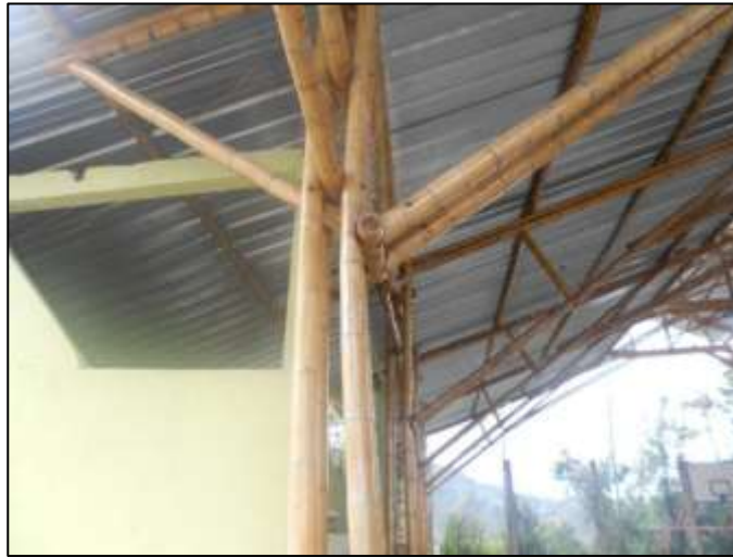
Ilustración 2. Pandeo en columna, cubierta La Soledad
