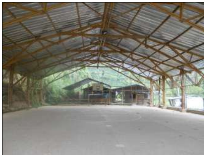
Ilustración 3. Vista general de la armadura, cubierta Puerto Alegría
