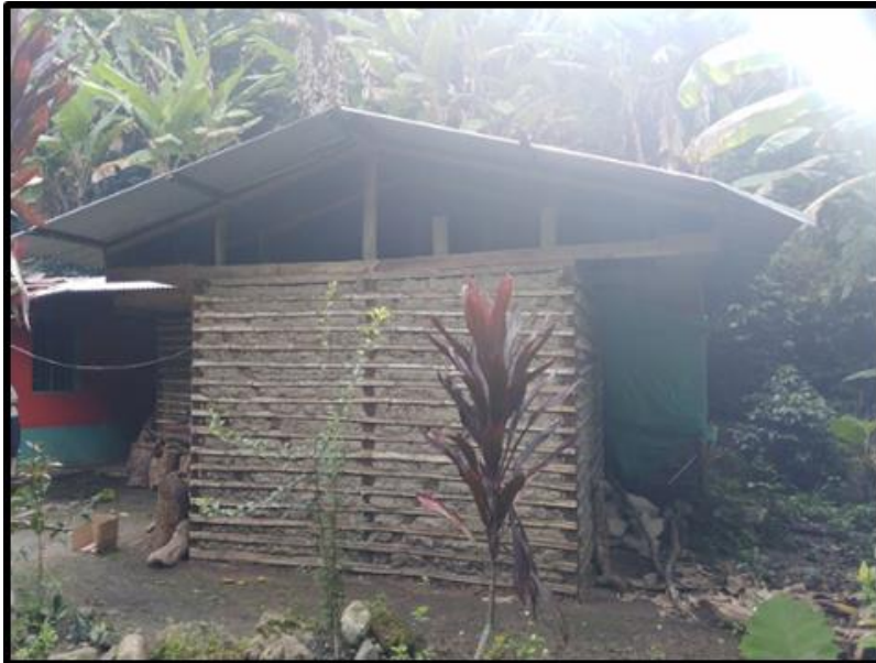
Figura 5. Construcción tradicional en bahareque, vereda la Virginia
