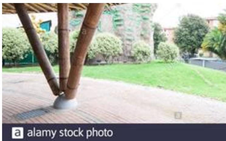
*Figura 12. Detalle Protección en columnas de domo Kiddies Parque Mundo Aventura*
