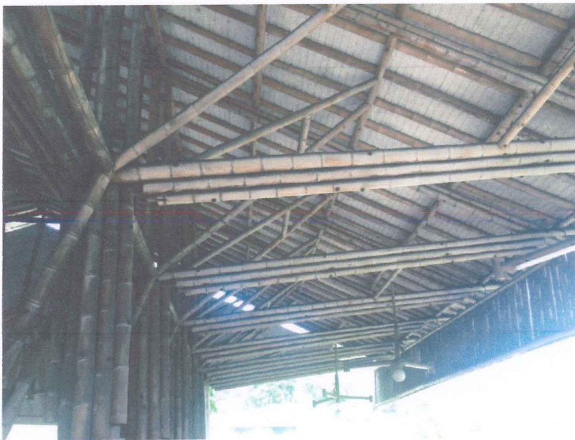
Aleros de cubierta (6 m), restaurante el ranchon (ARQ. Simon Velez)
