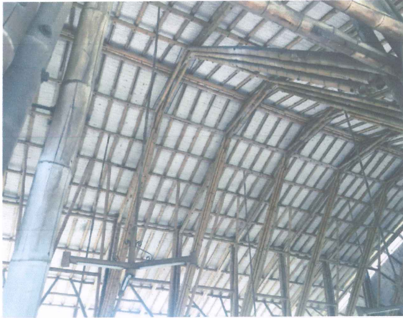
Estructura de Cubierta a dos agua, restaurante el ranchon (ARQ. Simon Velez)
