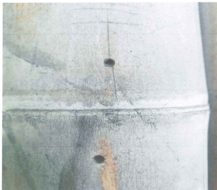
Agujeros de inyección, restaurante el ranchon (ARQ. Simon Velez)
