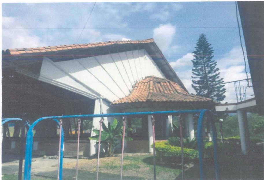
Fachada Costado oriental, restaurante el rancho (ARQ. Simon Velez)
