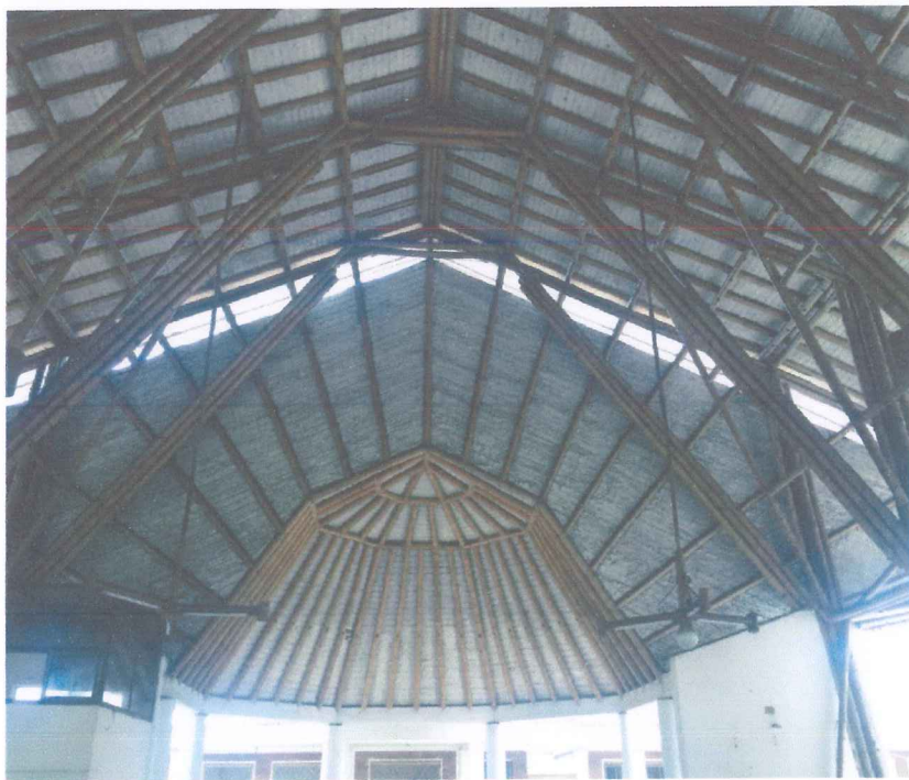
Culata de cubierta, restaurante el rancho (ARQ. Simon Velez)
