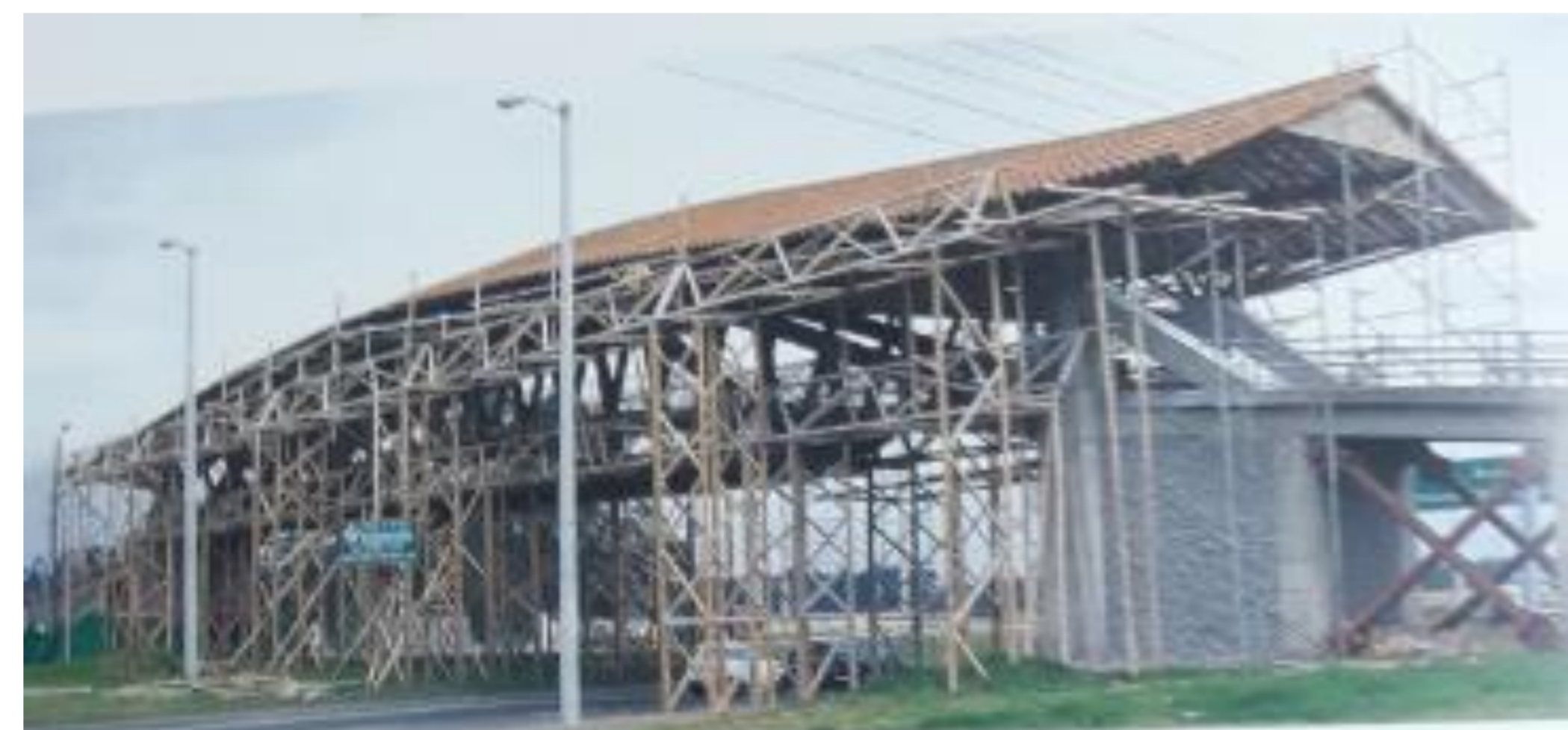
PUENTE EN EJECUCION CON SOPORTES TEMPORALES Y CUBIERTA EN TEJA DE BARRO Fuente: Villegas. M. (2003)
