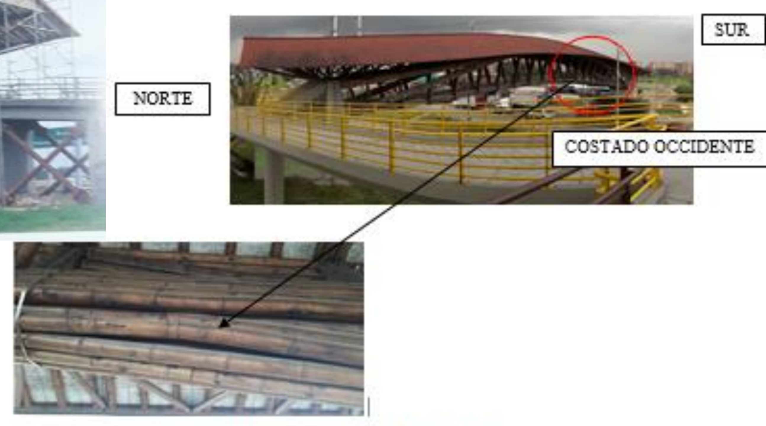
PUENTE EN EJECUCION CON SOPORTES TEMPORALES Y CUBIERTA EN TEJA DE BARRO Fuente: Villegas. M. (2003)
