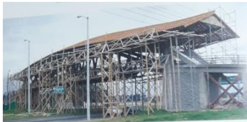
Figura 16 puente sostenido por apoyos temporales y con teja de barro,
