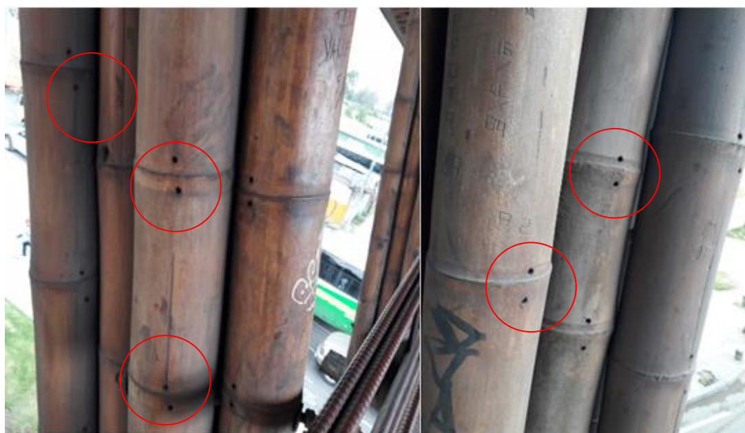
Figura 4 perforaciones para inyectar el inmunizante
