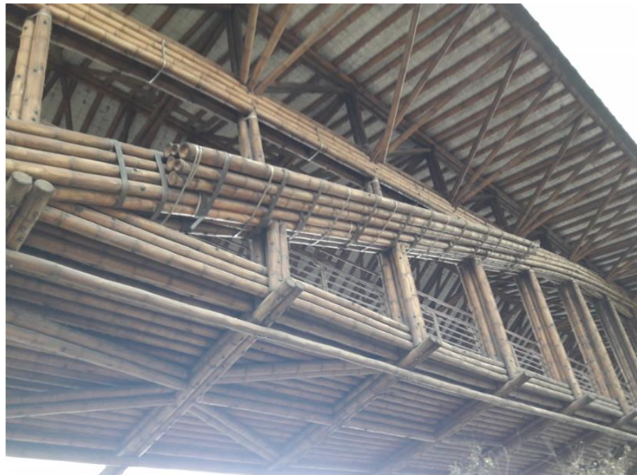
Figura 14 elementos continuos en arcos principales
