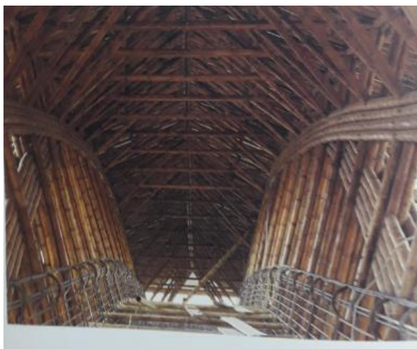
Figura 19 demolicion piso del Puente
