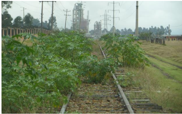
Figura 23. Estado actual vía Férrea. Fuente. Autor del proyecto.
