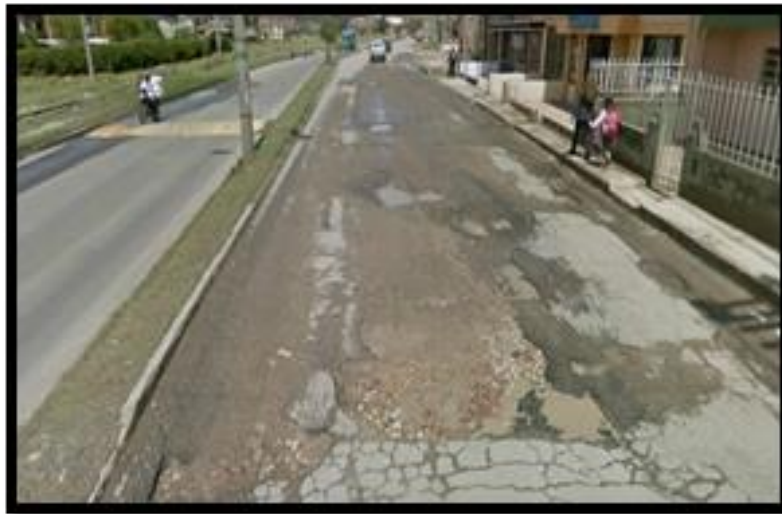
Figura 2. Condiciones de la malla vial carrera 11 . Fuente. Imagen tomada de google.maps
