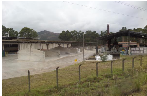
Figura 26. Empresa de construcción. Fuente. Autor del proyecto.
