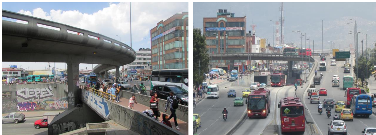
Imagen 63: Cruce vial actual Autopista sur y Av. 68
