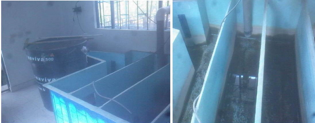
Figura No. 35. Canaleta Parshall
