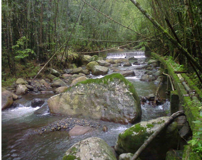
Fuente. Planta de tratamiento agua potable Sasaima Cundinamarca 2015
