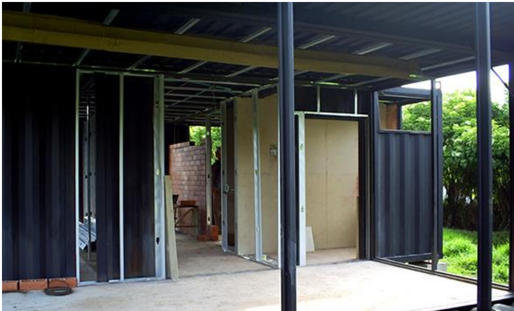
Imagen 47 “Instalación, ensamble y construcción” Adecuaciones interiores.
