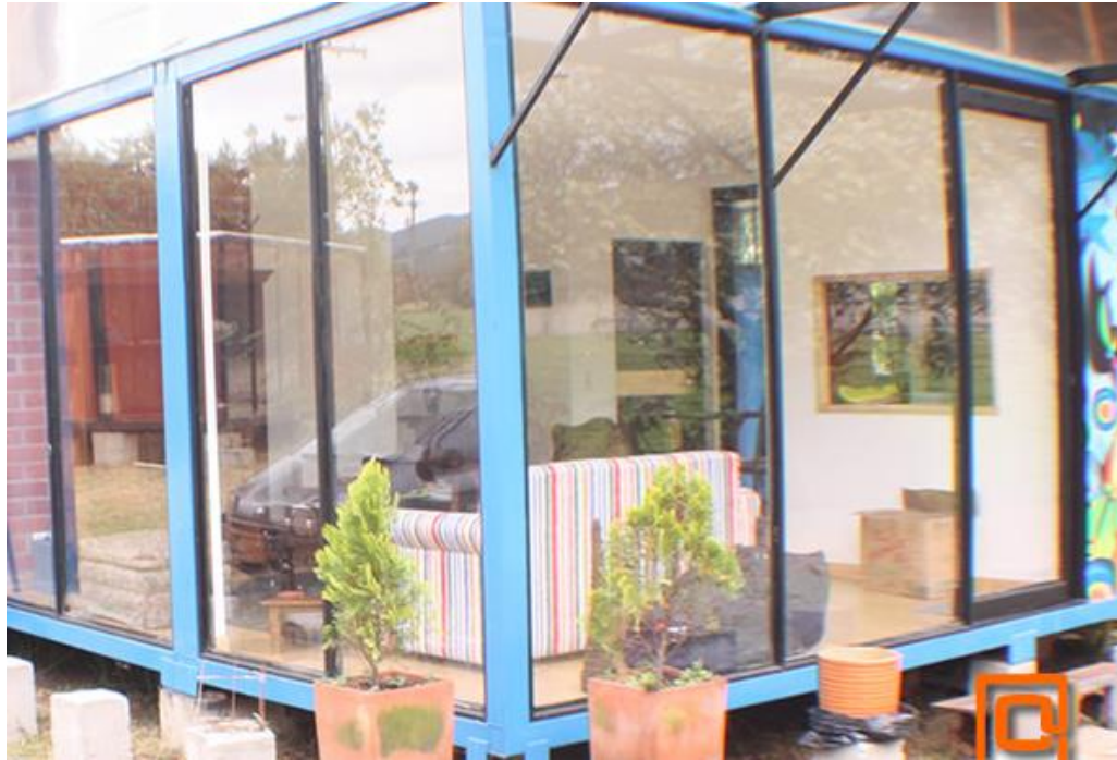
Imagen 54 “Instalación, ensamble y construcción” Proyecto ya realizado.
