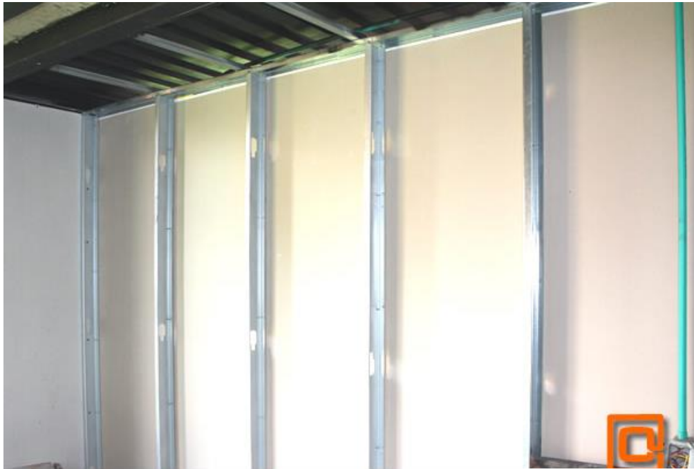
Imagen 52 “Instalación, ensamble y construcción” Muros internos en drywall.
