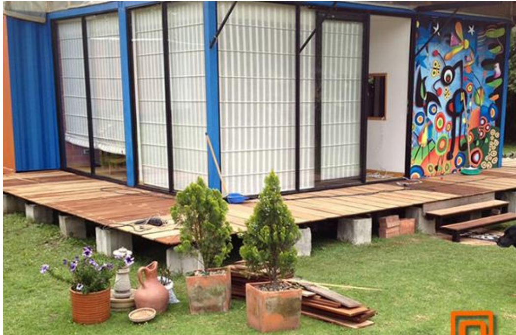
Imagen 56 “Instalación, ensamble y construcción” Proyecto ya realizado
