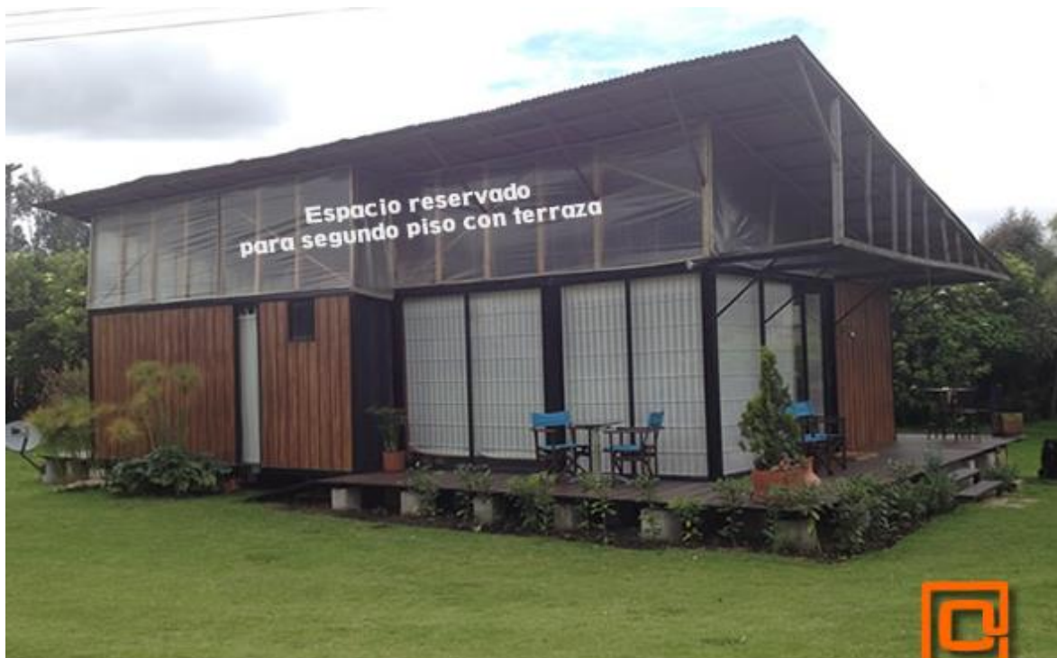
Imagen 55 “Instalación, ensamble y construcción” Proyecto ya realizado.
