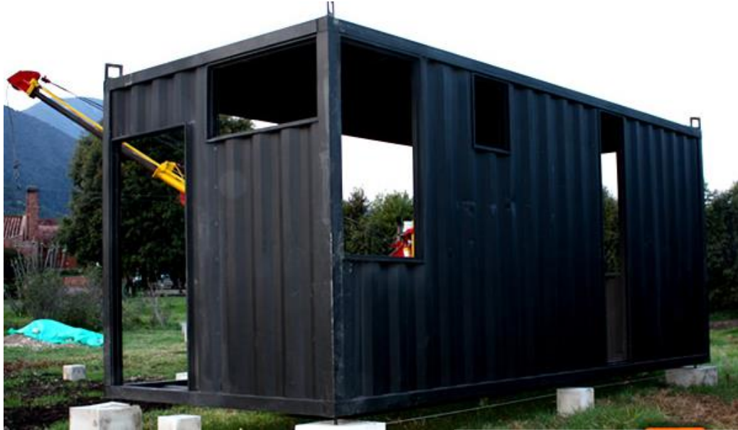
Imagen 46 “Instalación, ensamble y construcción” Ubicación sobre los mojones.
