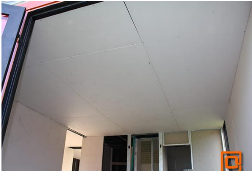
Imagen 53 “Instalación, ensamble y construcción” Cielo rasos en drywall.
