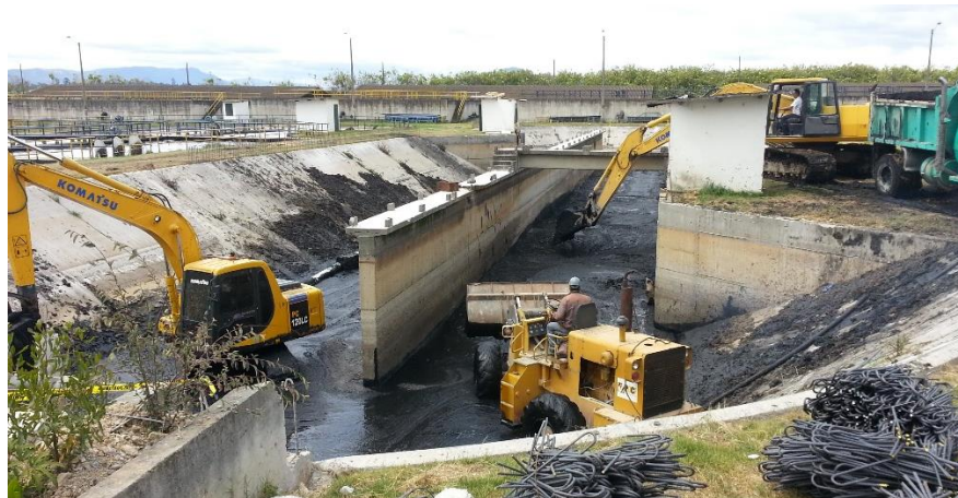
Imagen 1. Zanjón de oxidación PTAR Funza, año 2014
