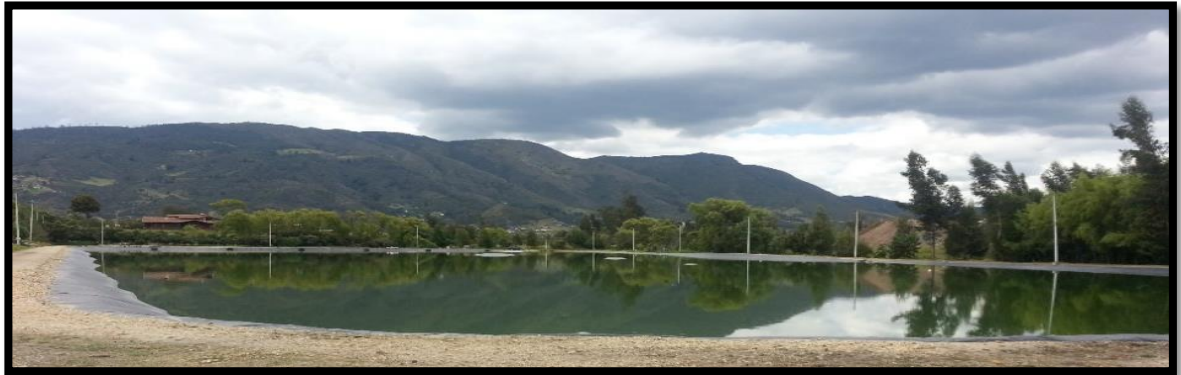
Imagen 12. Laguna de oxidación municipio de Tenjo
