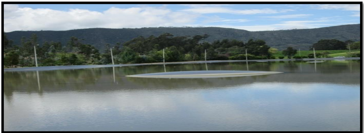
Imagen 16. Efecto ballena en laguna de oxidación
