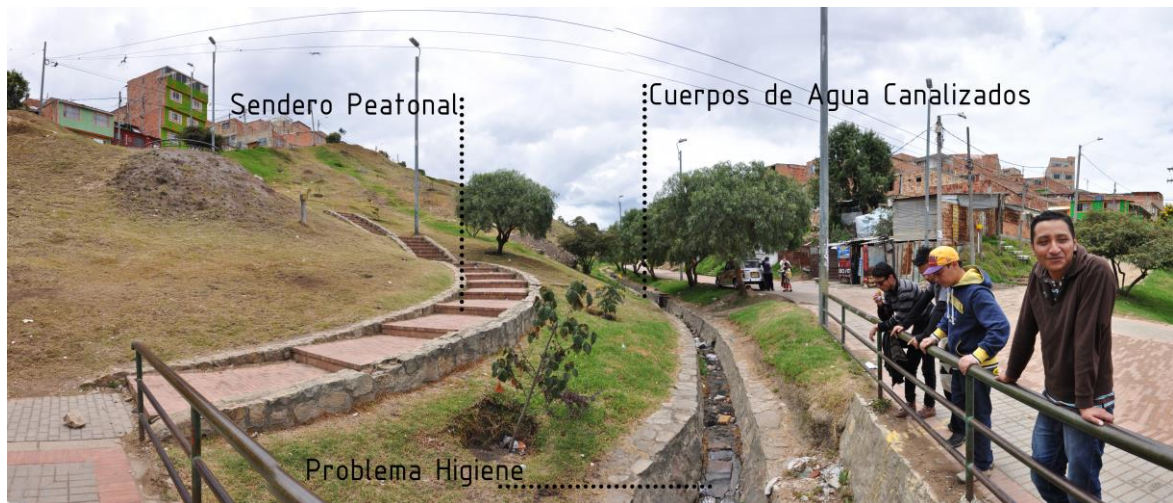
Ilustración 18 Fotos Sanjon de la muralla, cuerpo de agua en deterioro.
