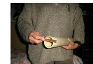
**PASO 4: ARMAR TODO EL CONJUNTO TAL COMO VA A QUEDAR, PERO SIN PEGARLO CON LA SOLDADURA, ASÍ SE PODRÁ ARREGLAR LOS IMPERFECTOS QUE QUEDEN. CUANDO SE TENGA TODO LISTO SE MARCA CON UN COLOR ROJO LOS EJES TANTO EN EL TUBO COMO EN LAS CAMPANAS DE LOS ACCESORIOS PARA QUE SIRVAN DE GUÍA CUANDO SE PEGUE CON LA SOLDADURA**
