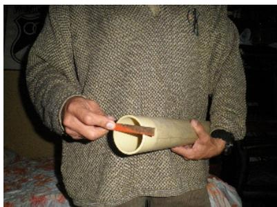
PASO 4: Armar todo el conjunto tal como va a quedar, pero sin pegarlo con la soldadura, así se podrá arreglar los imperfectos que queden. cuando se tenga todo listo se marca con un color rojo los ejes tanto en el tubo como en las campanas de los accesorios para que sirvan de guía cuando se pegue con la soldadura
