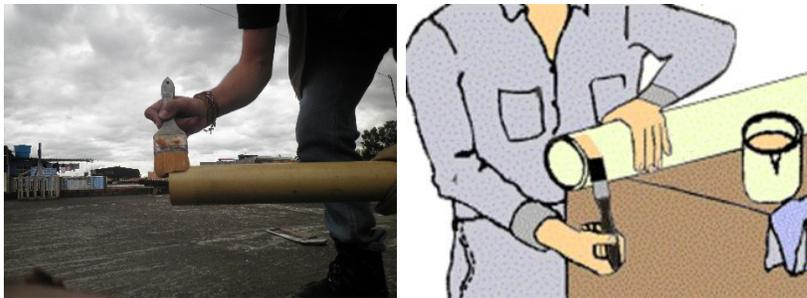
PASO 7: Aplicar soldadura a campana de accesorios: - se aplica abundantemente soldadura liquida PVC con una brocha en el interior de la campana del accesorio
