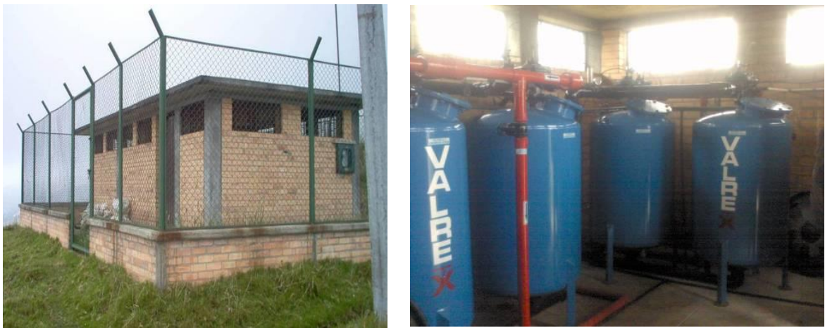
Figura 9. Planta de tratamiento y filtros.
