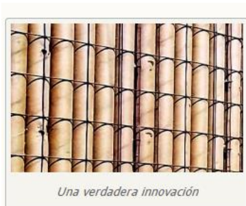
IMAGEN 5. Muro Can Tubo
