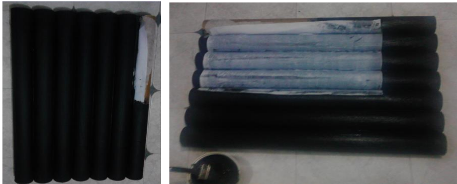
IMAGEN 30. Colocación de tela asfáltica sobre el panel
