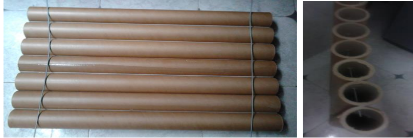
IMAGEN 28. Colocación de la varilla roscada en los tubos de cartón
