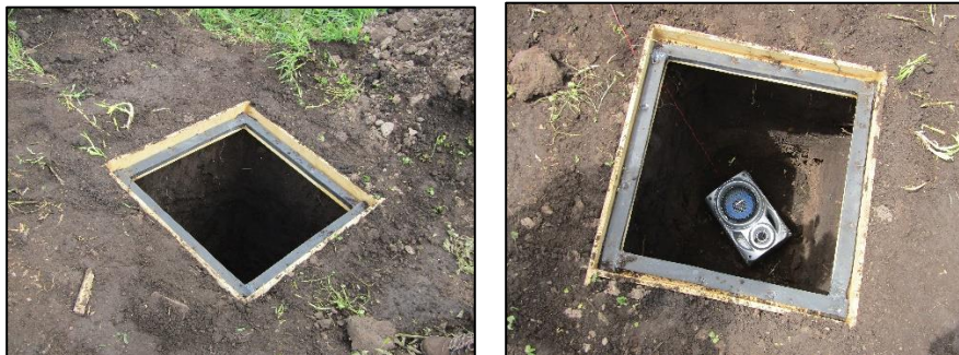
Figura 41: Sellado del marco, ubicación del bafle.
