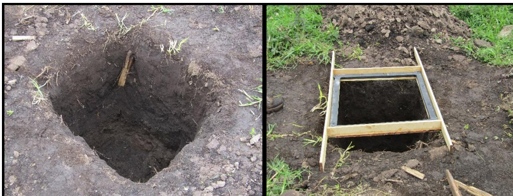
Figura 40: Excavación 1m de profundidad, montaje del marcó
