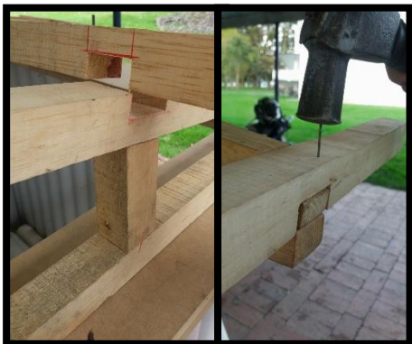
Figura 46 Acople durmientes
