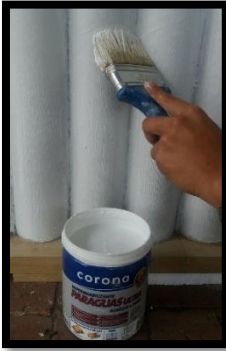
Figura 54 Aplicación imprimante e impermeabilizante
