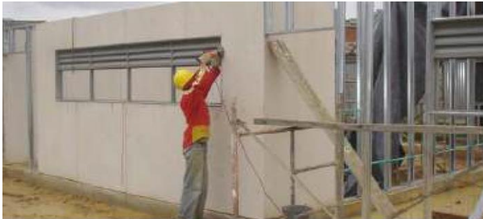
Figura 12 Reinstalación de lámina aula
