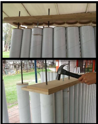
Figura 43 Fijación de la unión a los tubos
