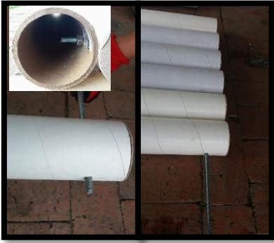
Figura 50 Anclaje de los tubos
