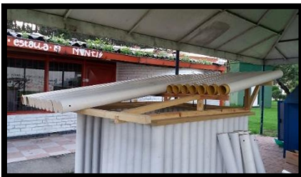
Figura 51 Ubicación de los tubos en la cercha
