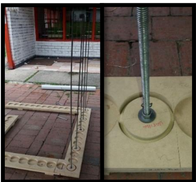
Figura 40 Anclaje tapón
