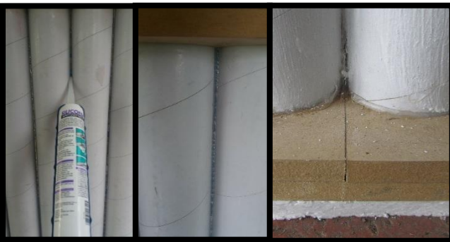
Figura 53 Aplicación del sellante
