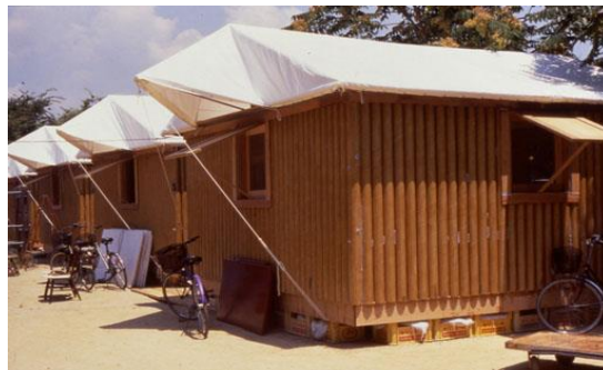
Figura 3 Vivienda emergente tubos de cartón
