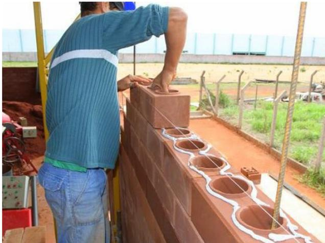
Ilustración 4. Sistema machihembrado de ecoblock, cantidad de mezcla usada para la pega de los ladrillos. Fuente: (Ecoblock, s.f.) Recuperado de: <http://ecoblock.mx/ventajas.html>
