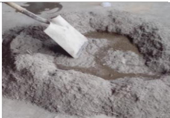
Ilustración 7: Mezcla de agregados secos con silicato de sodio y agua
