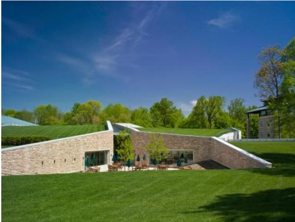
**Figura 3.** Tipo de cubierta verde extensiva
