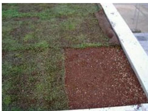
**Figura 6.** Sistema completo de tipo extensivo
