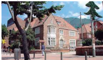
Imagen 54: edificacion estilo ingles. Fuente: tomado de http://4.bp.blogspot.com
