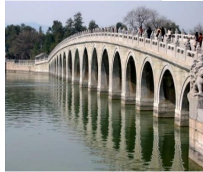
Ilustración 15 Puente de los 17 arcos
