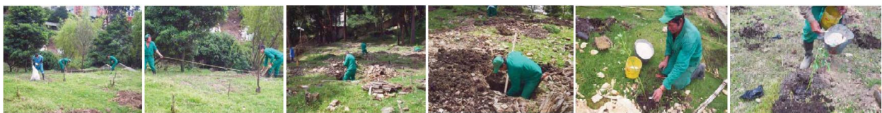
Fotografías: 6, 7, 8, 9,10, 11: Recuperación de quebrada Las Delicias
