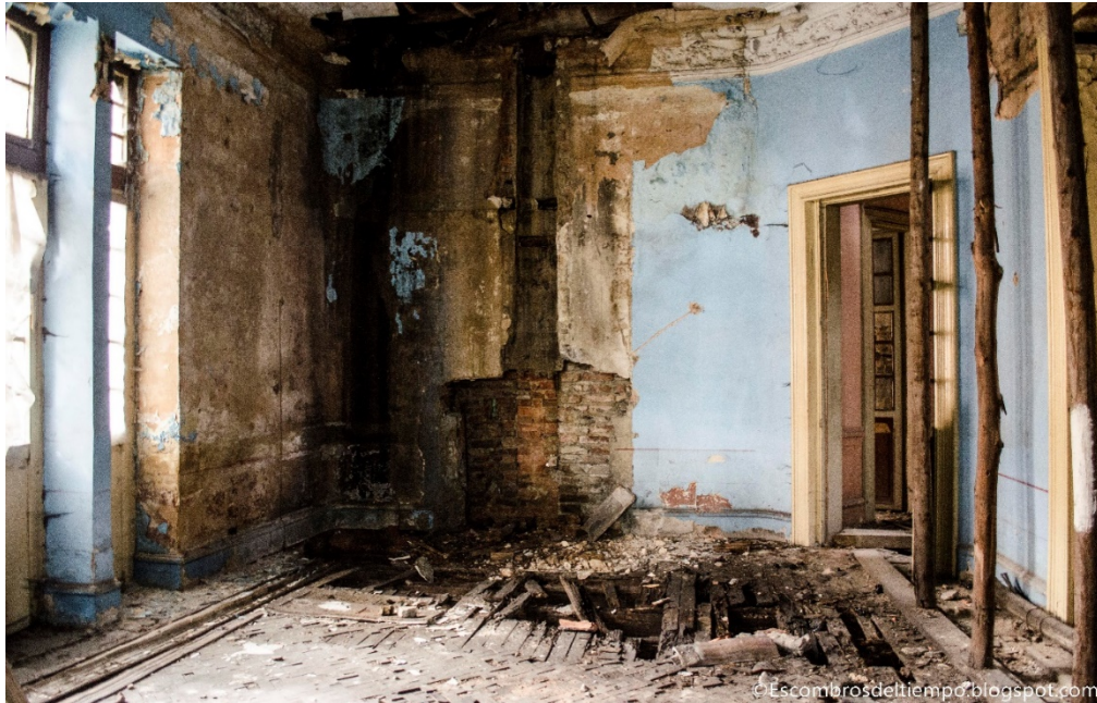
Imagen 13 Segundo piso Biblioteca Villa Adelaida
