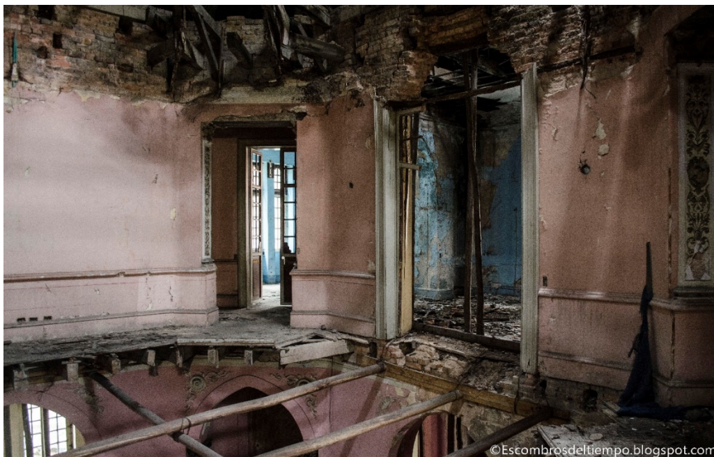
Imagen 12 Segundo piso Pasillo Villa Adelaida
