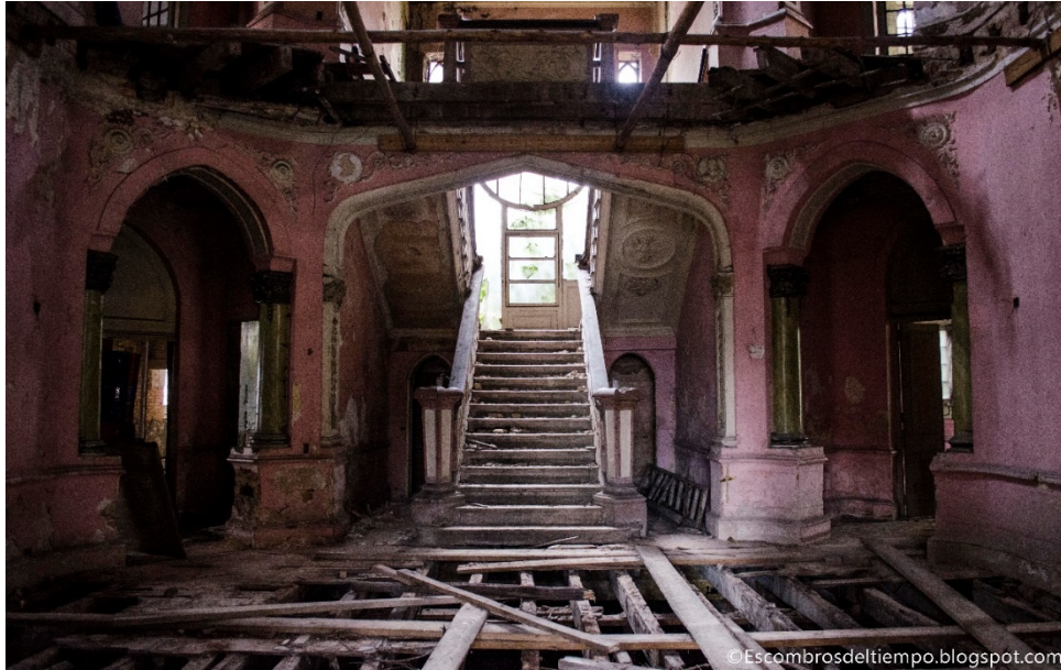
Imagen 10 Primer piso Vestíbulo Villa Adelaida
