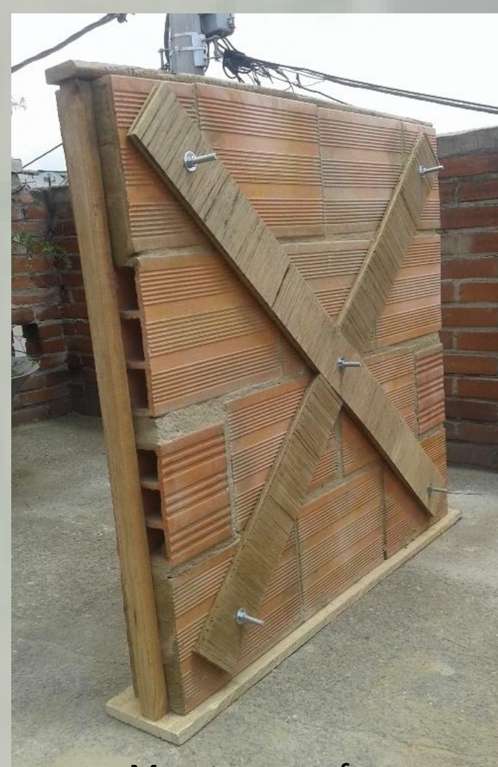
Murete con refuerzo
