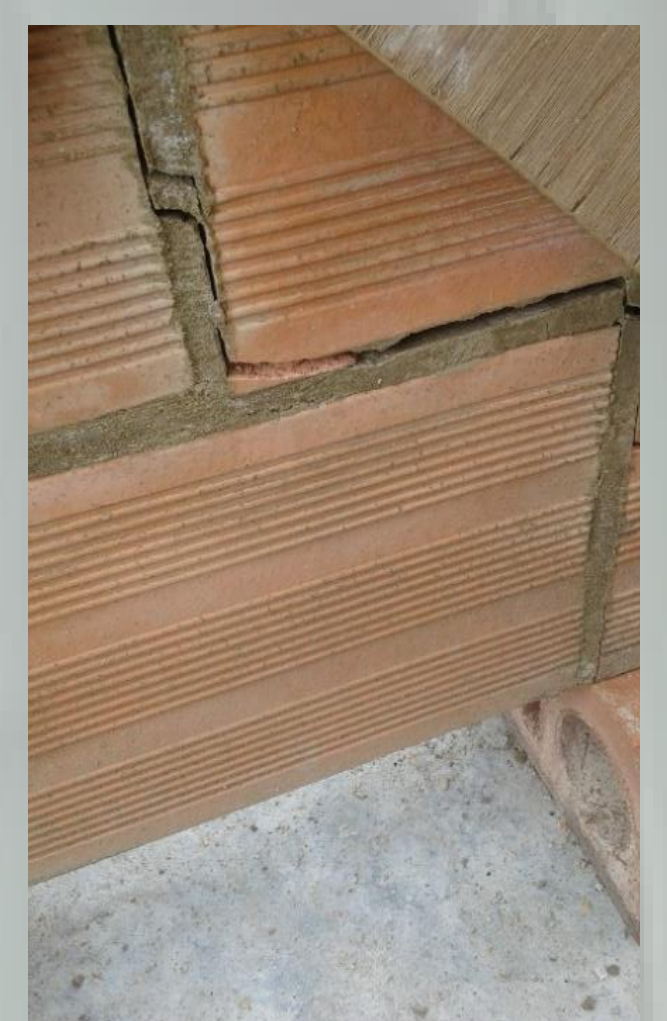
Fallo de murete
