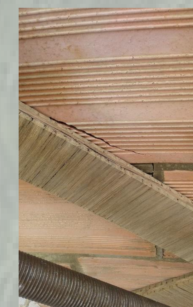
Fallo de murete
