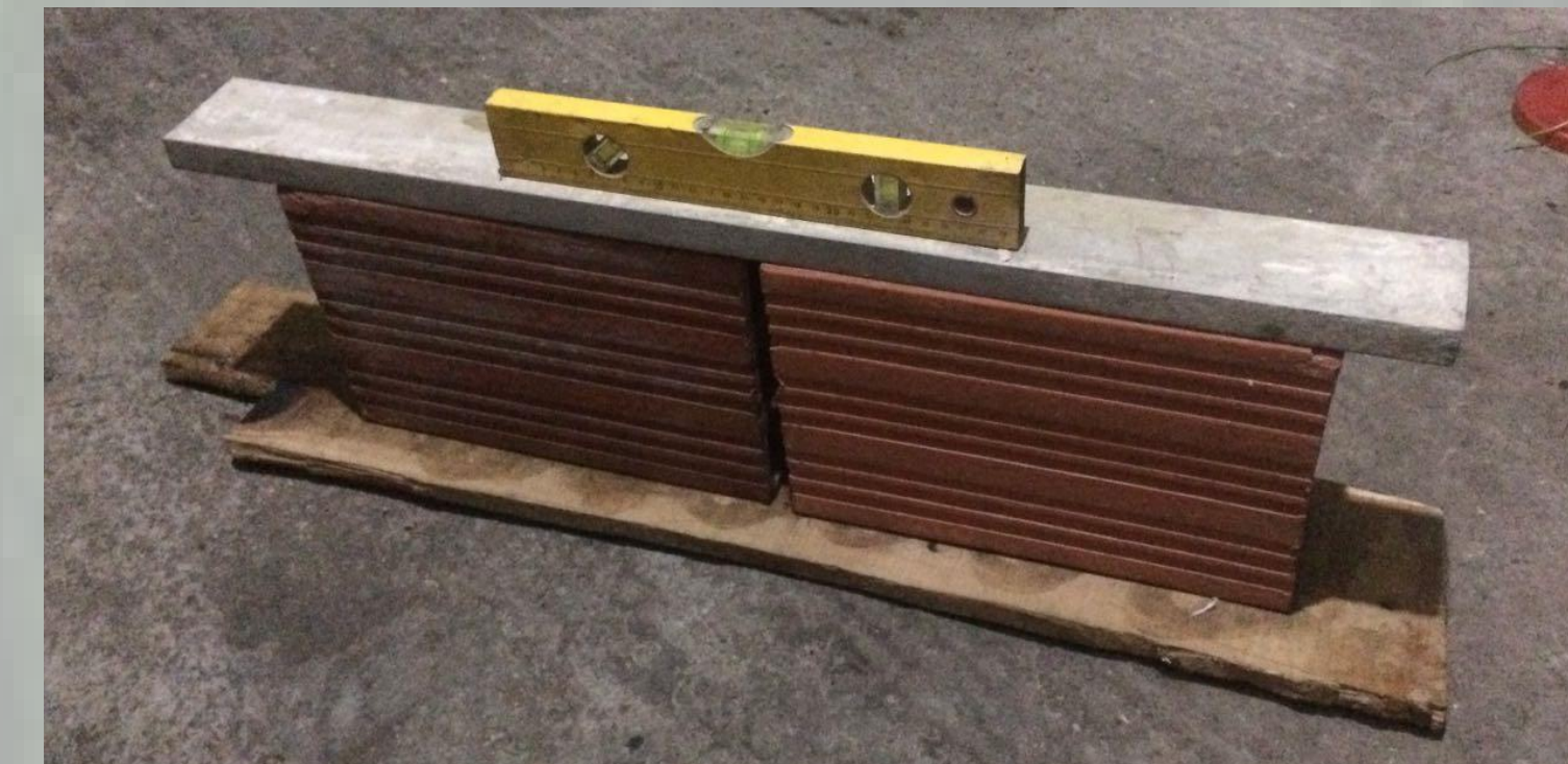
Colocación primera hilada
