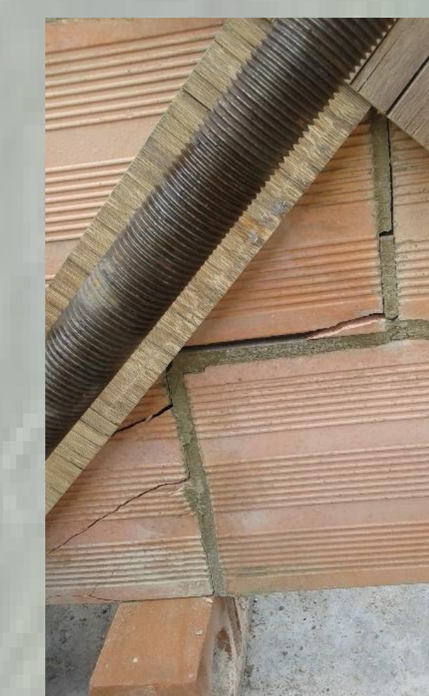
Fallo de murete
