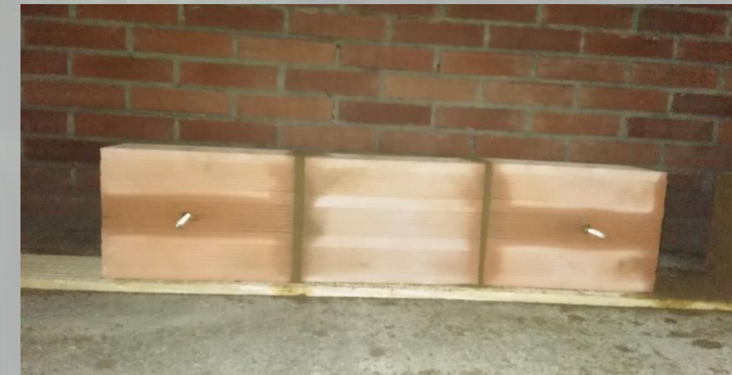
Terminación primera hilada con anclajes
