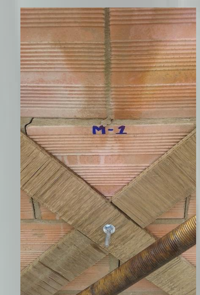
Fallo de murete
