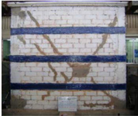
Imagen 65. Reforzamiento de muros con fibra de carbono
