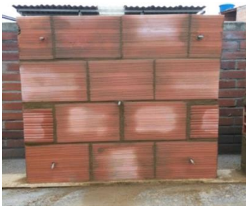
Un murete terminado
