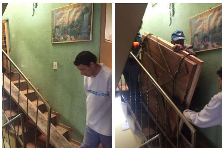
Imagen 57. Colocación tabla burra y Deslizamiento del murete
