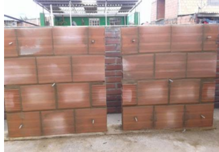
Dos muretes terminados
