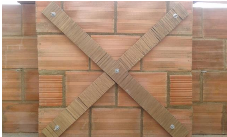
Imagen 68. Reforzamiento con listones en guadua
