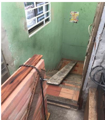
Imagen 53. Colocación tabla burra en la escalera
