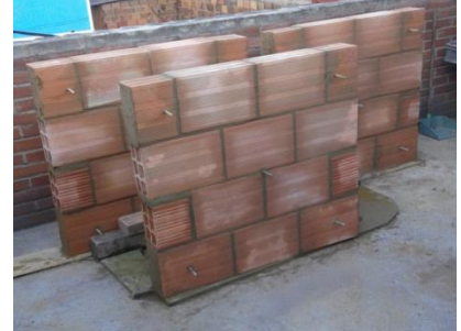
Tres muretes terminados
