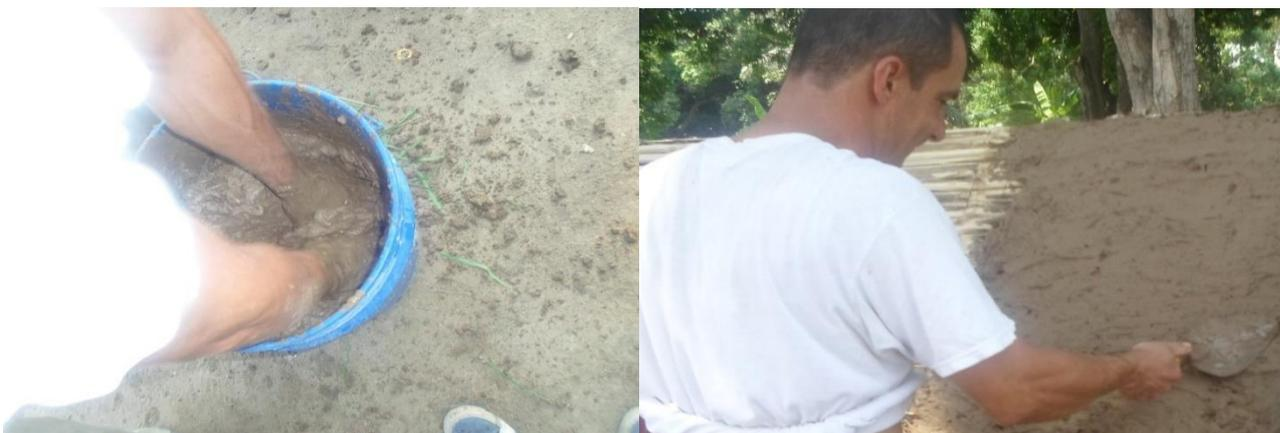
Figura 40. Instalación de la Composición de tierra como soporte a las tejas de totumo canal
