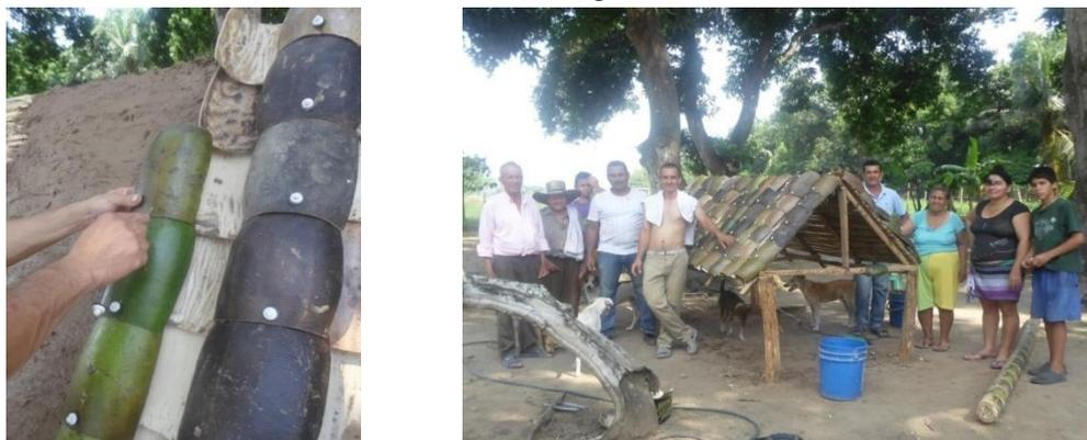
Figura 41. Instalación de las tejas en totumo a la estructura y terminación participativa de la comunidad
