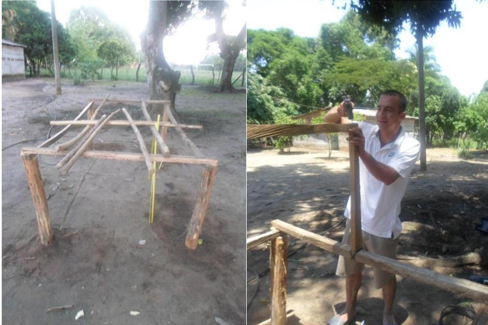
Figura 37. Instalación de la estructura en madera para el sistema constructivo
