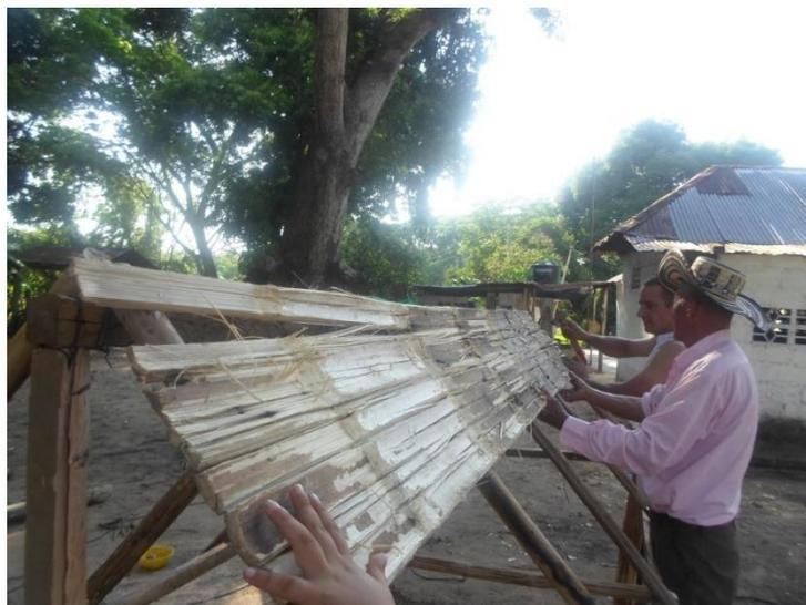
Figura 39. Abrir la guadua para esterilla e instalación de la esterilla a la estructura
