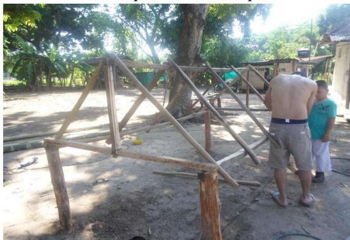
Figura 38. Instalación de las viguetas a la estructura
