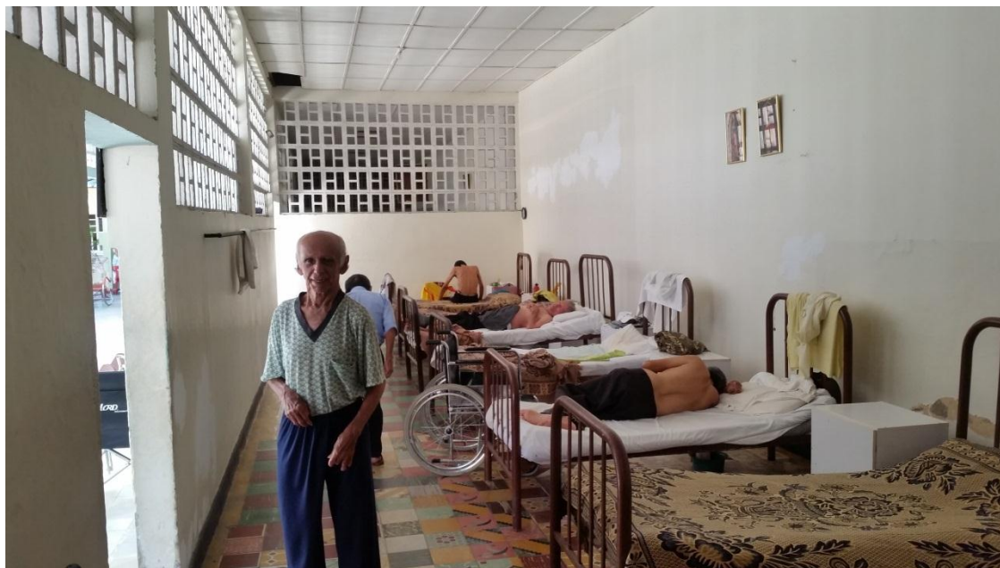
Ilustración 6: dormitorio varones, Fuente Reproducción propia. En los dormitorios es notable las aberturas de los muros, ausencia de puertas de acceso y de mobiliario que permita privacidad entre las camas y permitan la disminución de la reverberación acústica.
