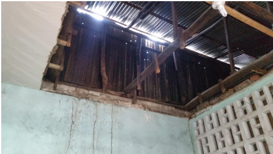
Ilustración 26 estado del cielo falso dormitorio varones, Fuente Reproducción propia.
