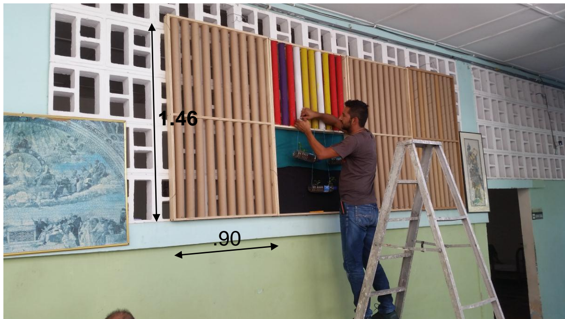
Ilustración 32 instalación prototipo cubreventanas en el sitio reproducción propia.
