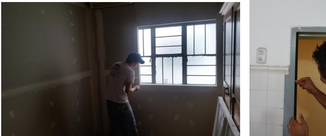
Ilustración 23. ejecución del contrato, insonorización puertas y ventanas.
