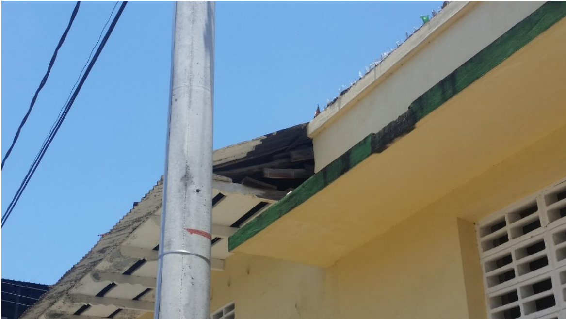
Ilustración 28 Estado del volado exterior de la cubierta, Fuente Reproducción propia.
