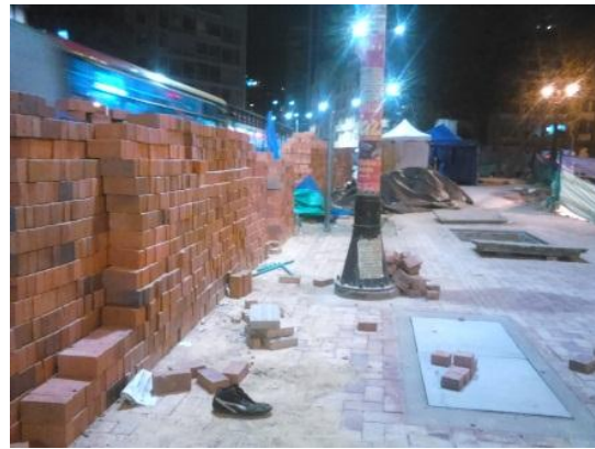
Figura 11 Renovación las Aguas
