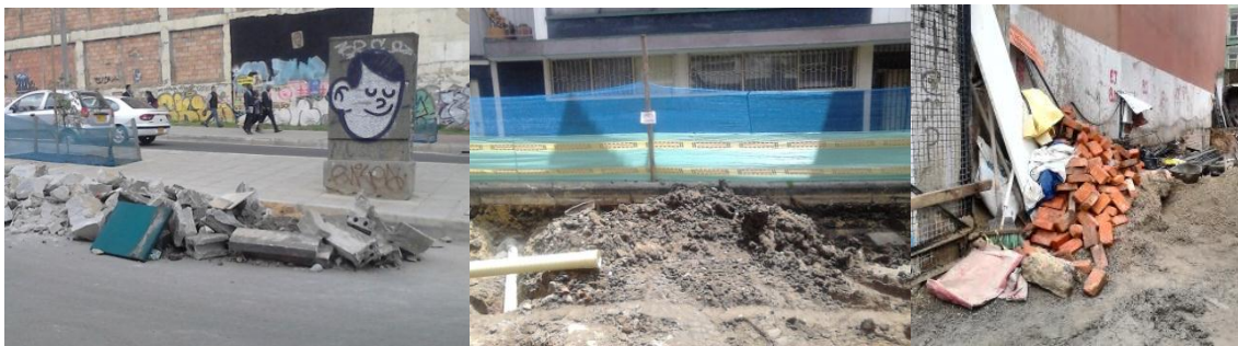
Figura 29 Escombros generados en obra - Autor
