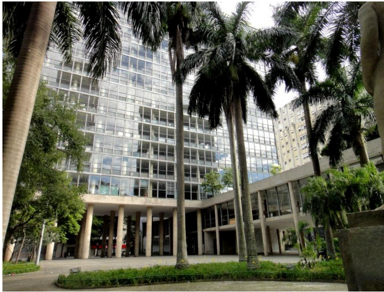
Figura 7. Pilotes de 10 mts de altura permiten la libre circulación por debajo del edificio
