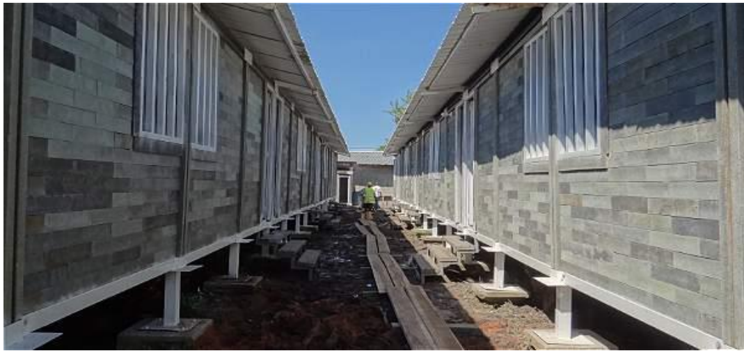
Figura 24: Viviendas con Ladrillo de Plástico Reciclado
