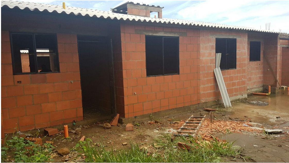
Figura 13: Vivienda de Interés Social Bifamiliar
