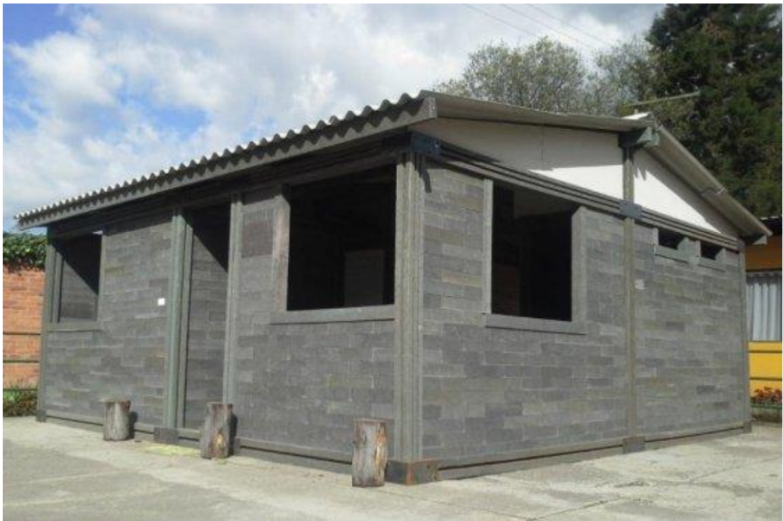
Figura 25: Vivienda con Ladrillo de Plástico
