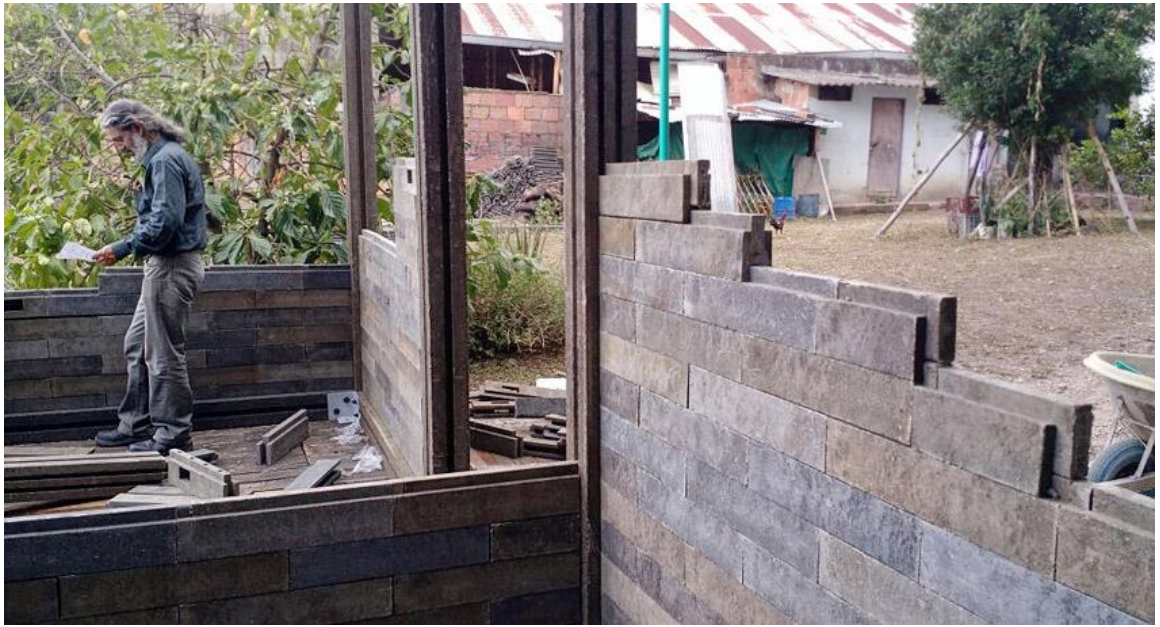
Figura 26: Proceso de Construcción
