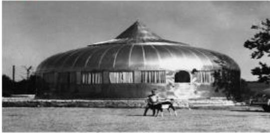
Había kits prefabricados que se ensamblaban in situ diseñados para ser adecuados para cualquier lugar o entorno y para usar los recursos de forma eficiente. Una consideración importante en su diseño fue la facilidad de transporte y ensamblaje.
