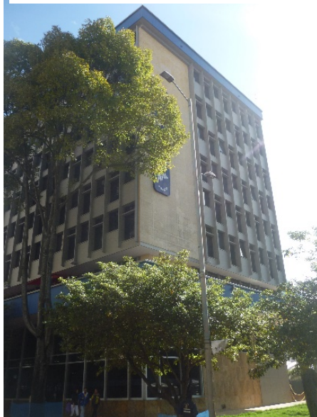
Fachada Edificio Icetex Fotografía propia
