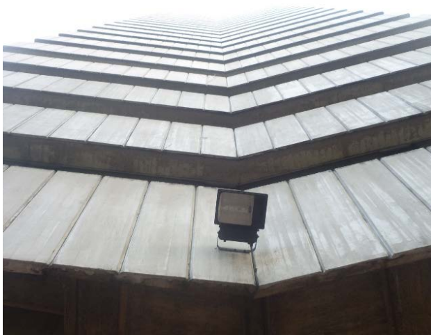
Prefabricados de Fachada Edificio Banco Ganadero Fotografía propia
