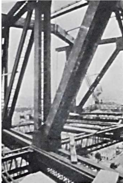
Estructura de Cubierta - Vigas metálicas tipo cajón Edificio Ugi Fotografía Revista PROA
