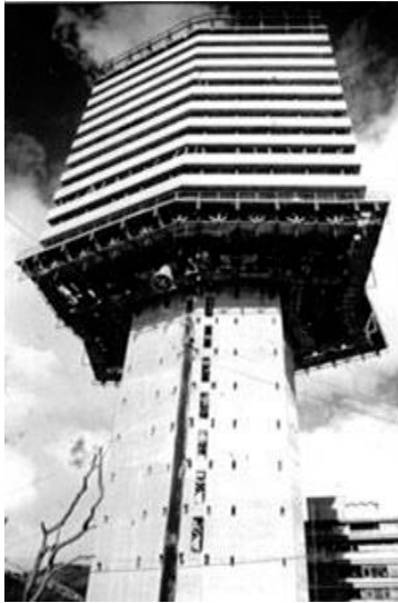
Núcleo central Edificio Ugi Fotografía Revista PROA
