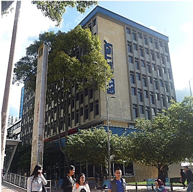
Fotografía propia Edificio Icetex Cra 3 # 17
