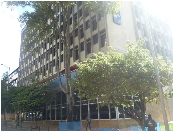
Fachada Edificio Icetex Fotografía propia
