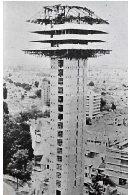
Proceso constructivo Edificio Ugi Fotografía Revista PROA
