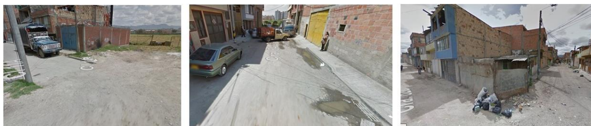
Vías sobre humedal de Techo. Vías sobre humedal del Burro. Vías sobre humedal de La Vaca.
