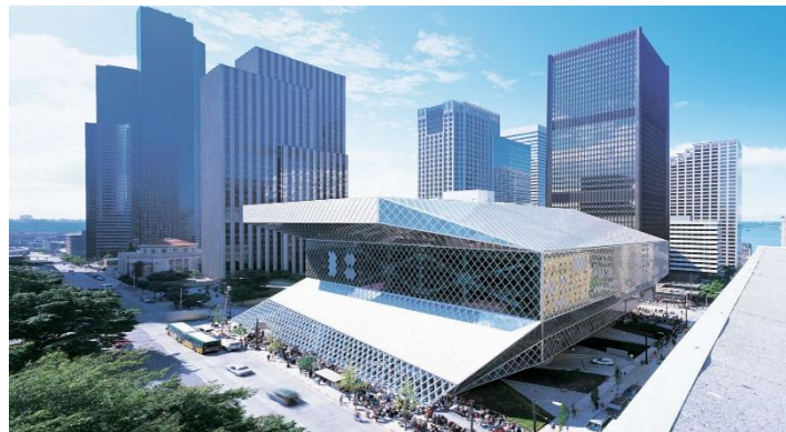
Figura 11: biblioteca de Seattle exterior
