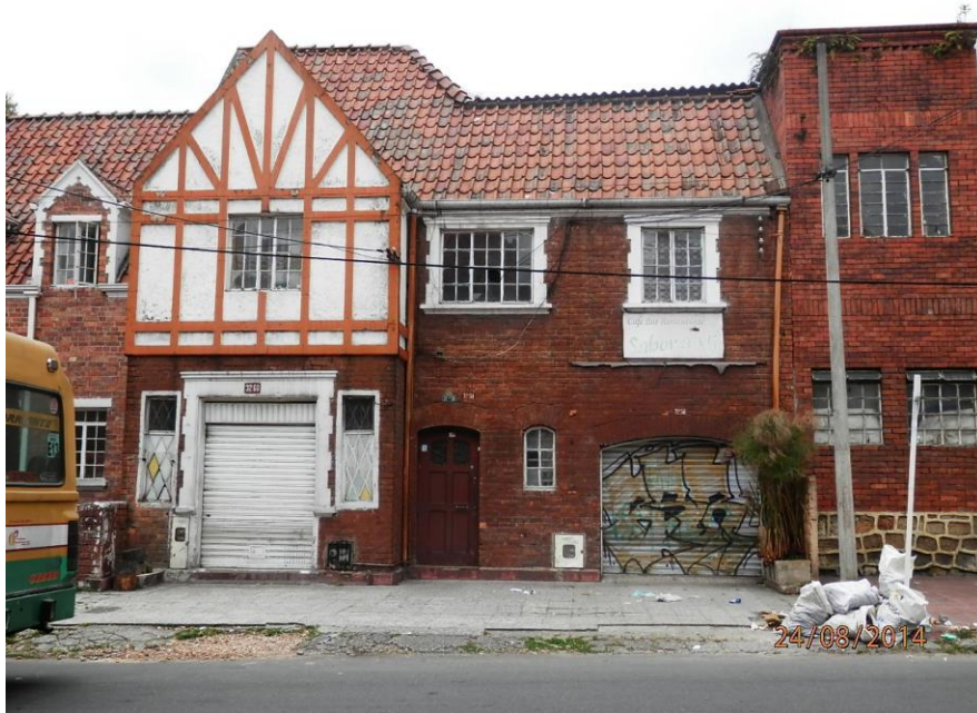
Imagen 1 Fotografía fachada inmueble y espacio público urbano. Fuente: Autor (visita de campo)
