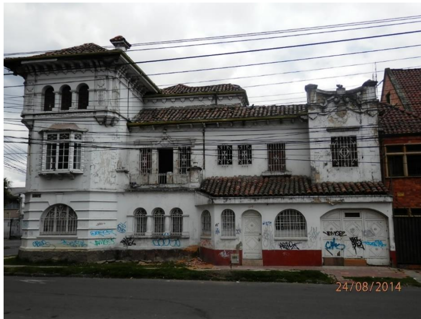
Imagen 2 Inmueble y espacio público deteriorado por abandono barrio Sur de Teusaquillo. Fuente: Autor (visita de campo)
