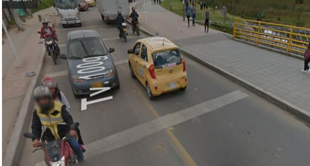
Figura 33. Bandas sonorizadoras de cemento en Transversal 100g por calle 71.
