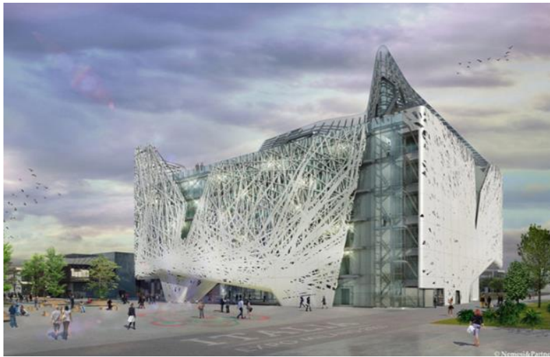
Figura 14. Pabellón de Italia Fachada
