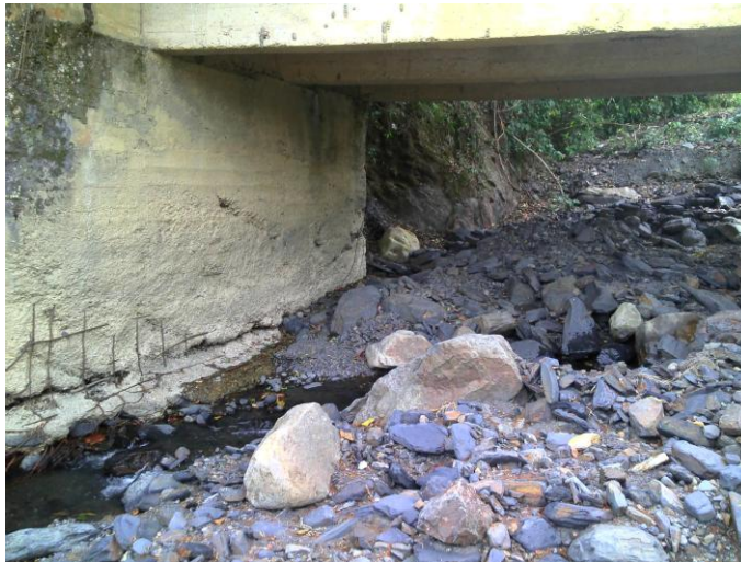
Fotografía 8. Exposición de los aceros de refuerzo de los estribos, igualmente su cimentación.
