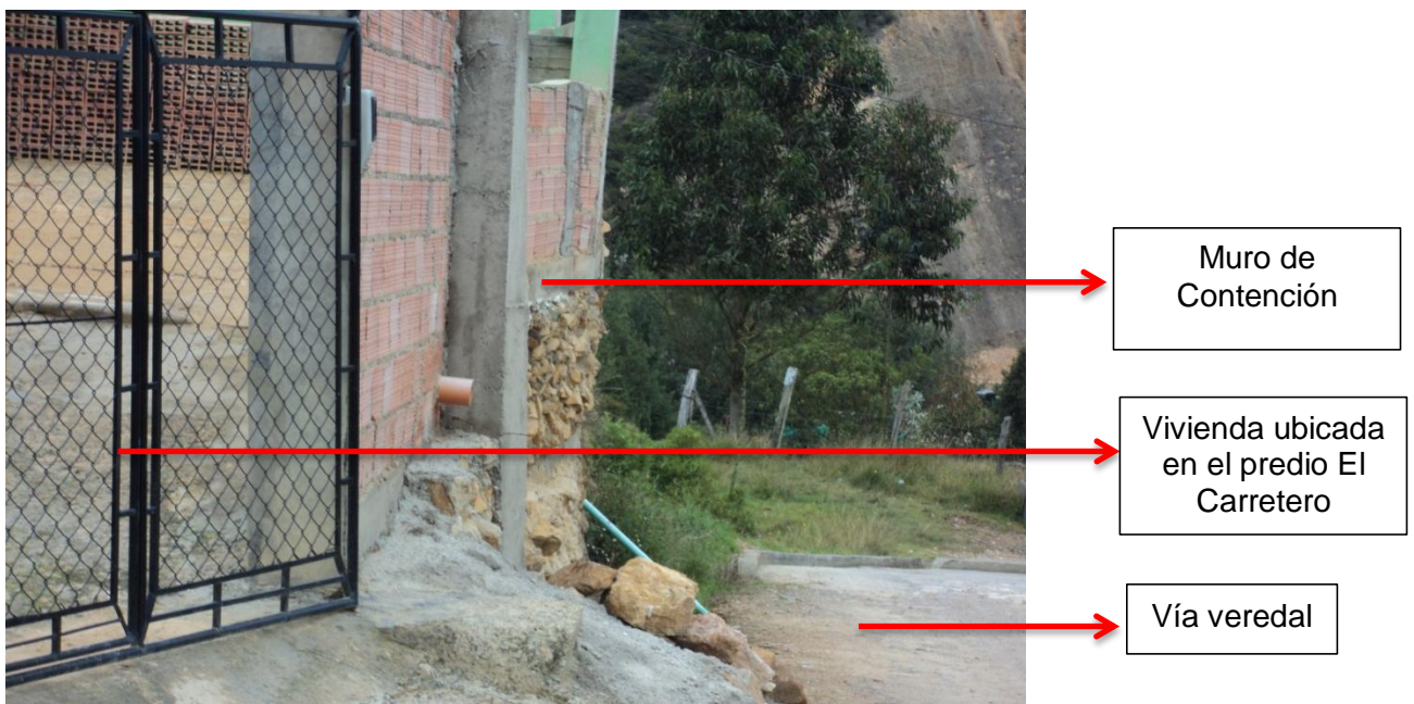
Foto 1. Ubicación muro de contención
