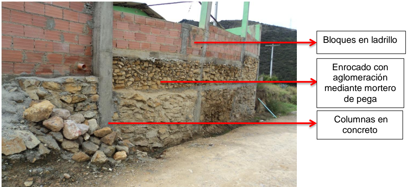
Foto 2. Muro de contención y cerramiento
