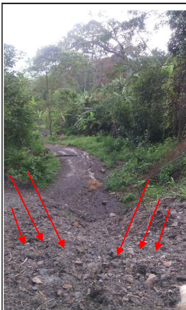
MATERIAL REMOVIDO Y DEPOSITADO SOBRE EL PASO VEHICULAR
