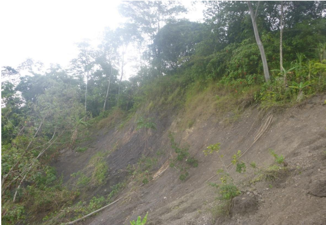
Fotografías N° 3 Nótese la cicatriz de falla distinguida por un aparente movimiento rotacional descrito mediante una curva en la corona del talud. Fuente propia
