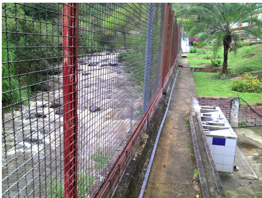
Fotografía 1. Instalaciones ubicadas en zona de ronda. Nótese la presencia del muro de contención (reconocible únicamente desde una vista frontal). Presenta malla de cerramiento y se encuentra en contacto directo con el cuerpo de agua. Fuente propia
