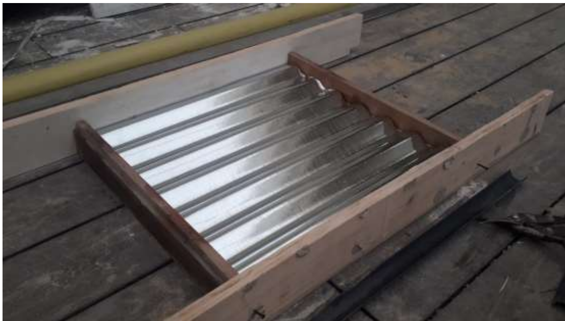
Figura 6. Diseño de la formaleta para la elaboración del panel – 2018.
