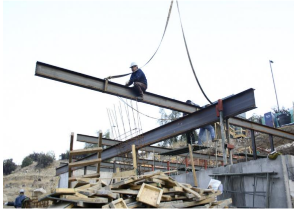
FIGURA 9 MONTAJE ESTRUCTURA METÁLICA
