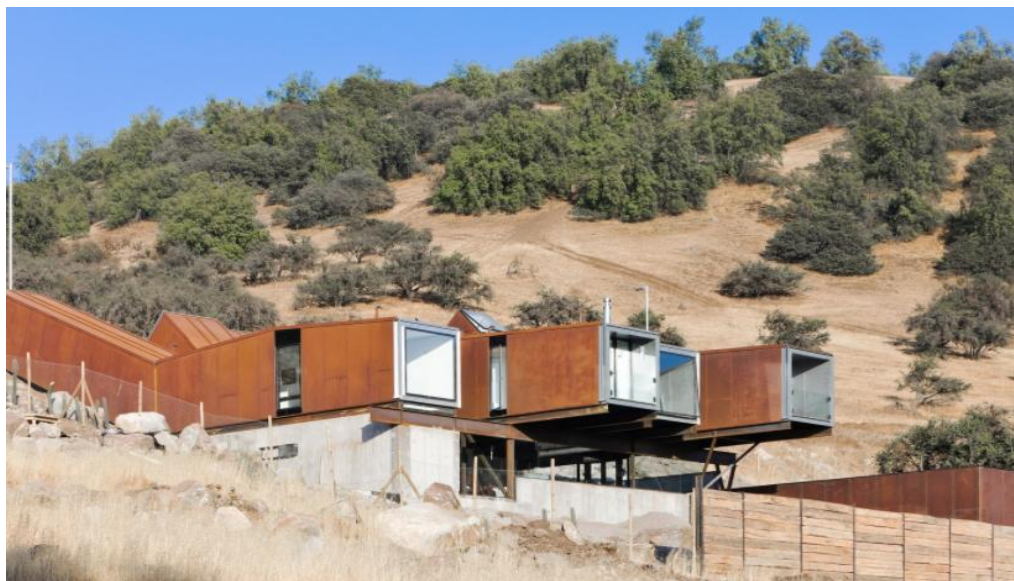
FIGURA 8 VISTA CASA ORUGA
